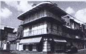
2 ème prix : 2 500€ Immeuble Halley à Pointe-à-Pitre SCI Halley Maison d'angle de ville, à usage mixte de commerce et d'habitation en dur, sur deux étages, et un galetis en bois, ornée de balcons d'angle en fer forgé, entièrement restaurée à l'identique dans le cadre de la rénovation urbaine.
