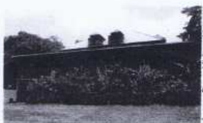
3 ème prix ex-aequo : 1 500€ Maison Gabillet à Vieux-Habitants Mme Valérie Gabillet Ancienne maison de maître en rez-de-chaussée de l'habitation caféière Getz (fin XVIII e ème). Rénovée en 1980, elle a conservé son architecture d'origine, ses bardages en mahogany et ses menuiseries anciennes.
